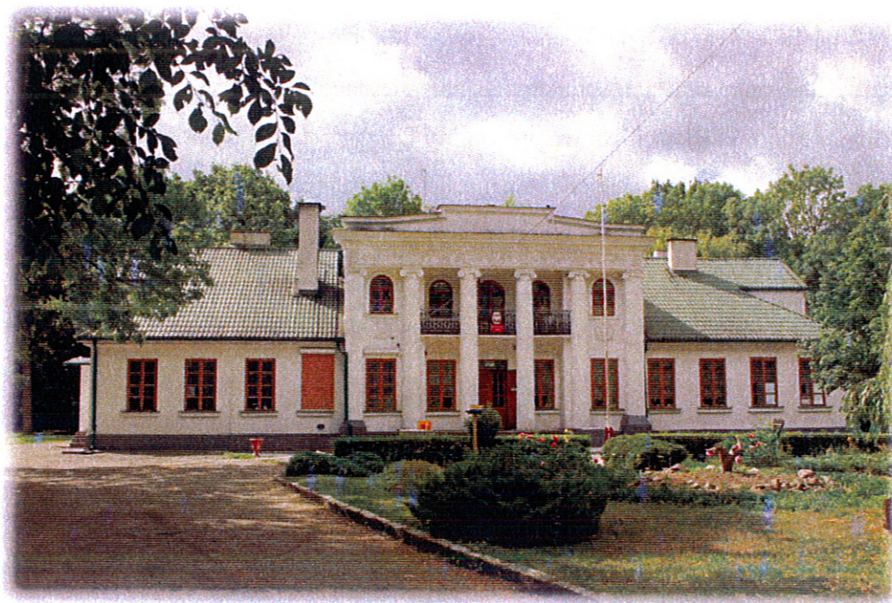
Elewacja frontowa dworu w Dyblinie
