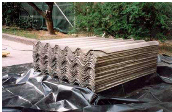
Przygotowanie odpadów azbestowych do transportu
