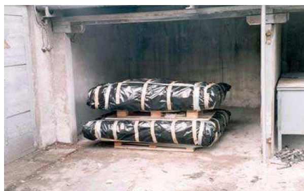
Przygotowanie odpadów azbestowych do transportu
