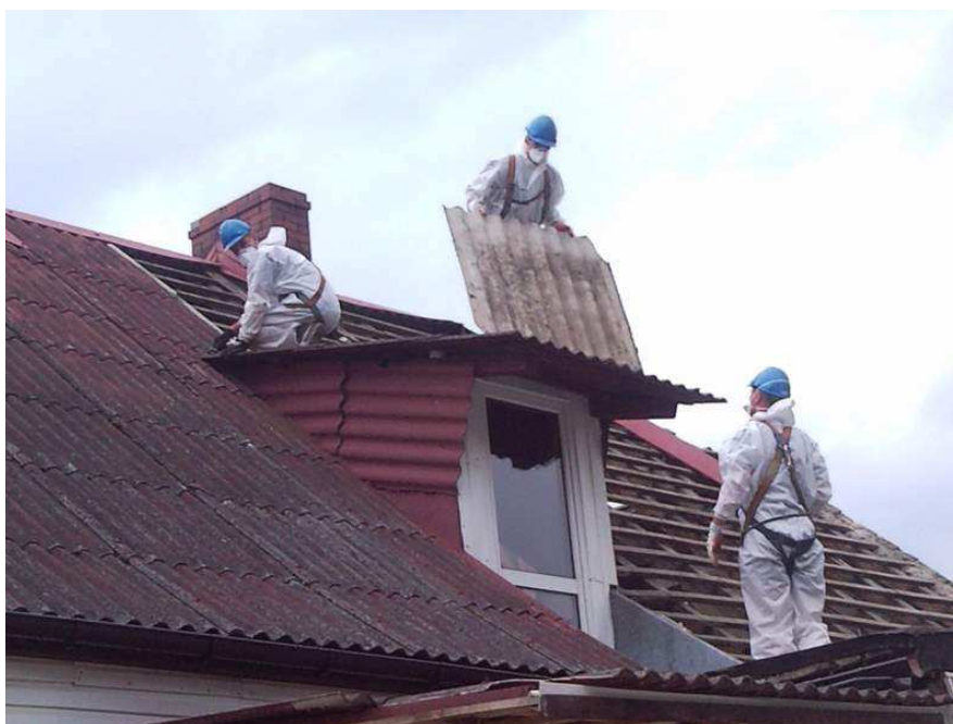
Demontaż płyt eternitowych
