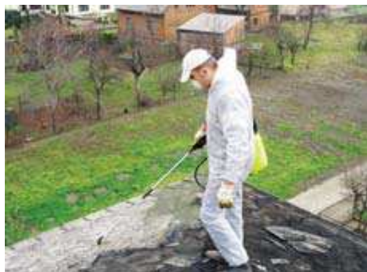
Nawilżanie płytek dachu wodą za pomocą spryskiwacza
