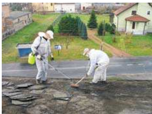
Oczyszczanie terenu prac z pozostałości eternitu poprzez zmiatanie na mokro
